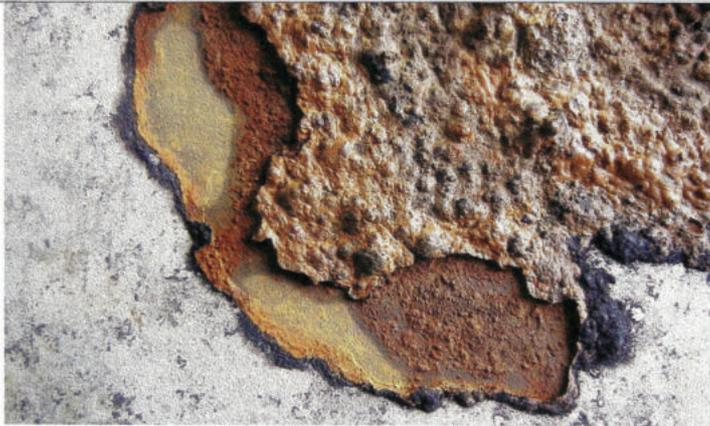
Korrosionsschäden durch weiches Wasser
